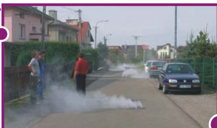
Sprawdzanie szczelności rurociągów kanalizacyjnych i przyłączy domowych. Lokalizacja nielegalnych podłączeń wód opadowych.
