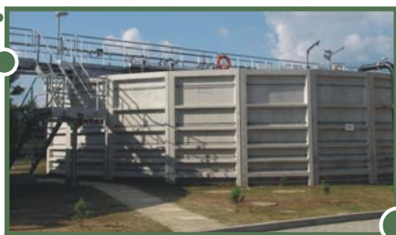
Oczyszczalnia ścieków w Gdowie
