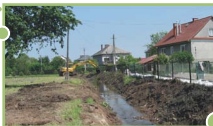
Konserwacja rowu melioracyjnego w Gdowie
