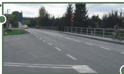
Nowy chodnik i nawierzchnia drogi 966 Bilczyce - Gdów
